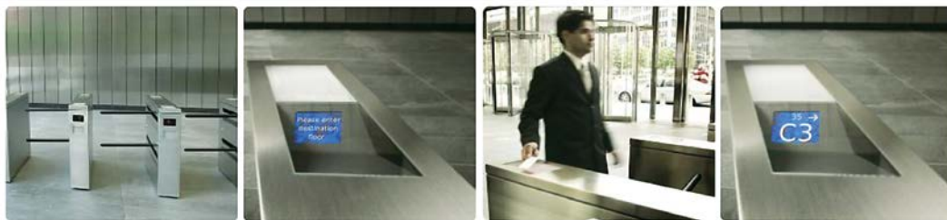
Rys. 1. Zasada współpracy systemu kontroli dostępu Inner Range z systemem zarządzania windami Otis CompassPlus™
