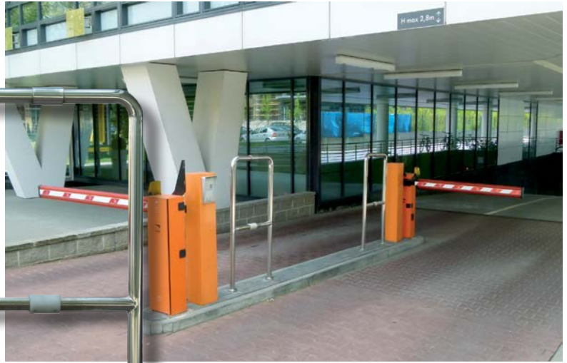
Rys. 3. Kontrola wjazdu na parking biurowca w Warszawie
