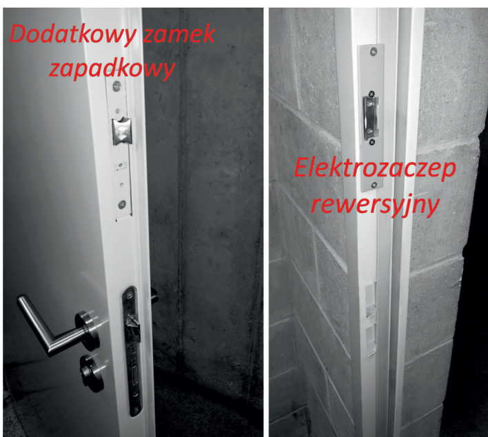
■ Rys. 2. Dodatkowy zamek zapadkowy i elektrozaczepek rewersyjny (NO) w zastosowaniu do dwustronnej kontroli dostępu na drzwiach przeciwpożarowych
