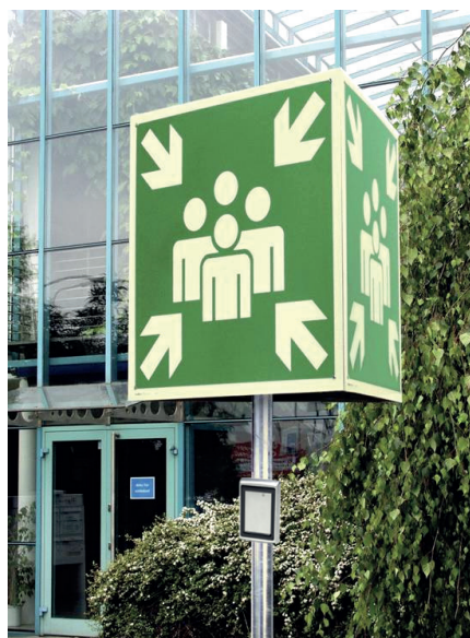
Rys. 3. Miejsce zbiórki do ewakuacji z czytnikiem do realizacji funkcji sprawdzania obecności
