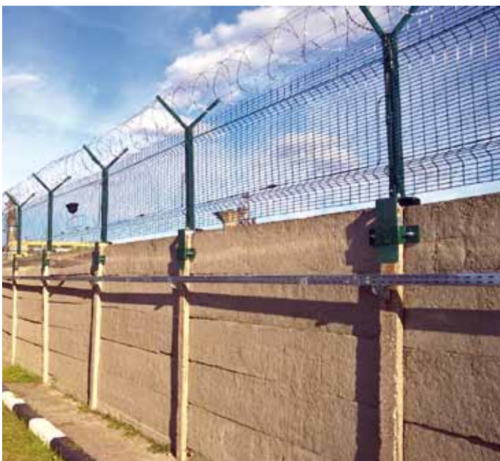
Rys. 11. Zabezpieczenie ogrodzenia zakładu karnego kablem sensorycznym
