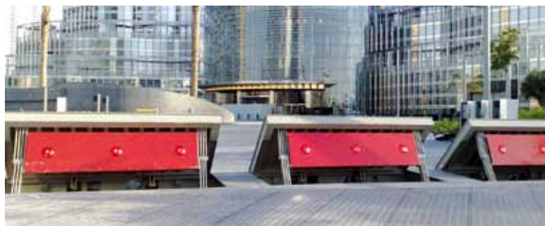
Rys. 1. Zapory klinowe podnoszone z poziomu drogi typu Wedge w czasie badania najazdowego i w obszarze miejskim Zdjęcia – Gunnebo Polska
