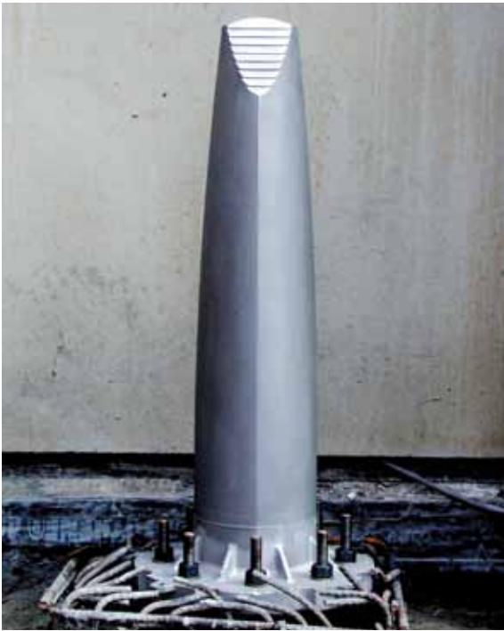
Rys. 1. Pacholek antytaranowy zaprojektowany na zamówienie przez Ricka Reedera, zakotwiczony w betonie zbrojonym Zdjęcie – designStream Rick Reeder
