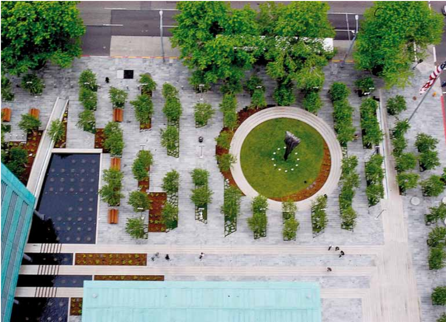
Rys. 5. Szpalery drzew, słupki antyterrorowe, betonowe „ławki”, ławki tradycyjne zakotwiczone w gruncie, „pułapka” w formie niecki z miękkim gruntem, schody i wielopoziomowe kaskady wodne przed budynkiem Sądu Federalnego w Seattle
