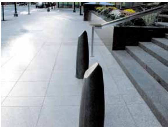
Rys. 2. Słupki antyterrorystyczne przed wejściem do bostońskiego budynku 100 Federal
