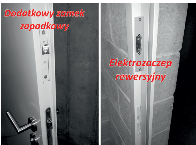
Rys. 8. Dodatkowy zamek zapadkowy i elektrozaczep rewersyjny (NO) 5 w zastosowaniu do kontroli dostępu na drzwiach przeciwpożarowych
